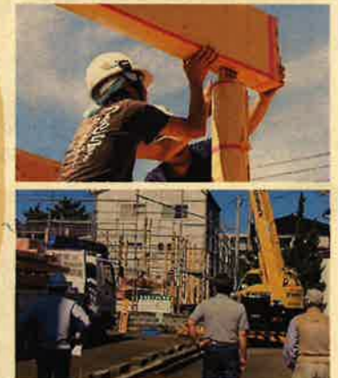
Y様邸の建て方作業の様子。
