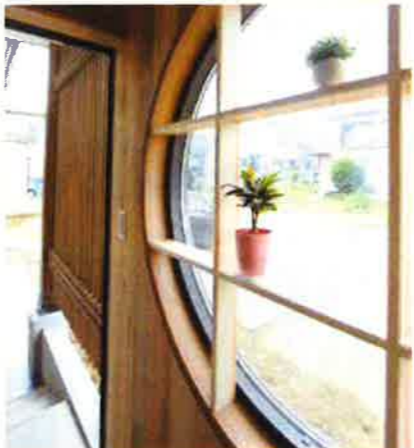
玄関のアクセントに丸窓を。格子は大工の手作り
